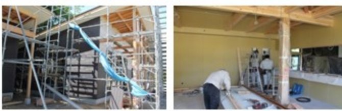
外装・内装工事に着手
