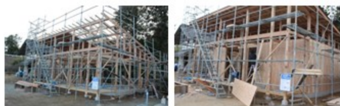
いよいよ建屋工事に着手
