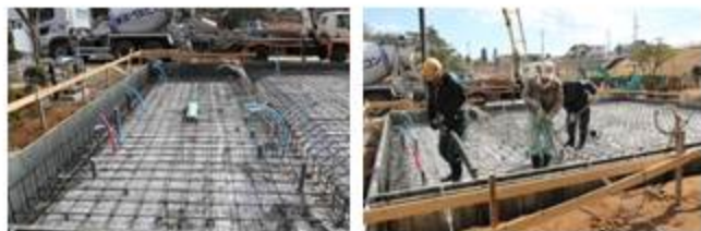
基礎部分の生コン打設の様子 = 3月3日
