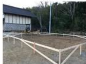
移動した蔵とカフェの基礎丁張と暗渠設置の様子
