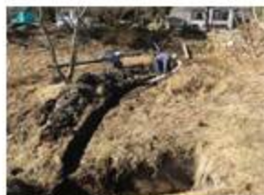
移動した蔵とカフェの基礎丁張と暗渠設置の様子
