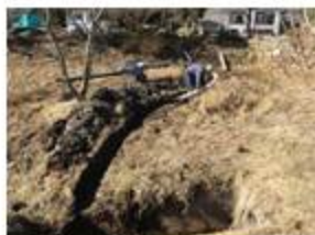
移動した蔵の横の基礎丁張と暗渠設置の様子
