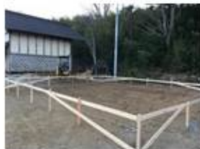
移動した蔵の横の基礎丁張と暗渠設置の様子
