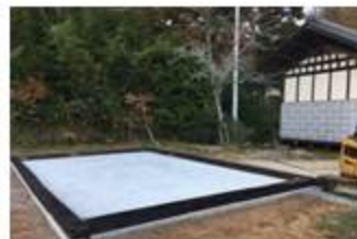
曳家の移設先の基礎になる生コン打設の様子＝11月1日
