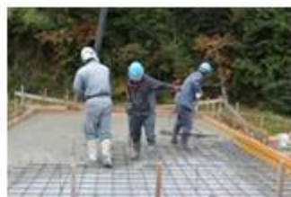
曳家の移設先の基礎になる生コン打設の様子＝11月1日
