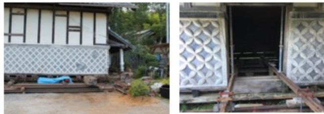
曳家の準備としてジャッキアップされた蔵、外観・内部の様子
