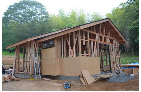
6月18日撮影。屋根が完成し外壁工事中
